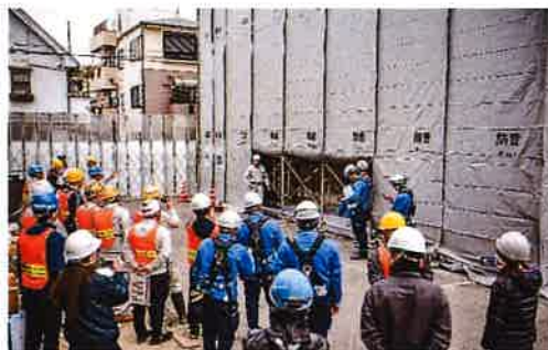
超高压水洗工法説明の様子
