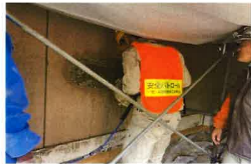
超高压水洗工法体験の様子
