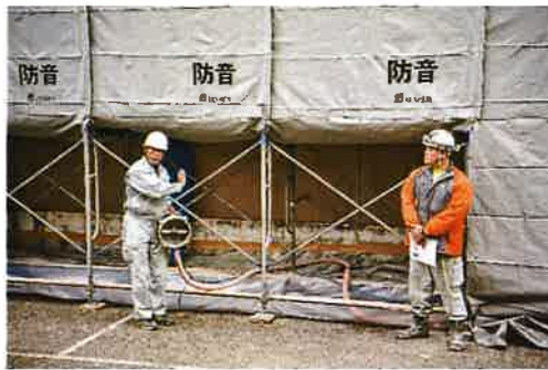
超高压水洗工法説明の様子
