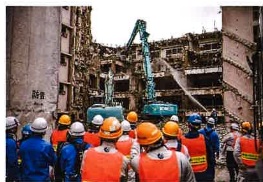
安全パトロール実施の様子
