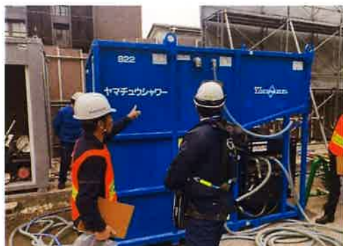
安全パトロール実施の様子
