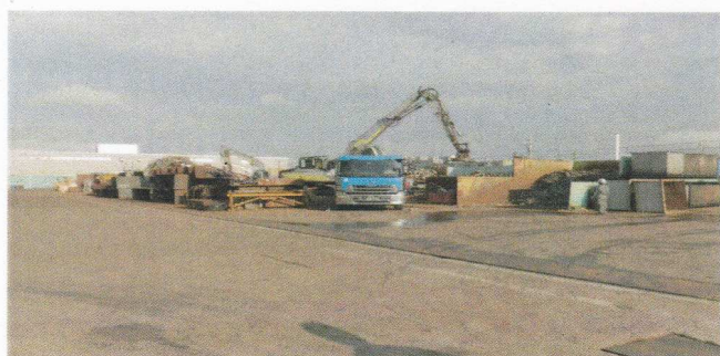
大型鉄製品の解体
