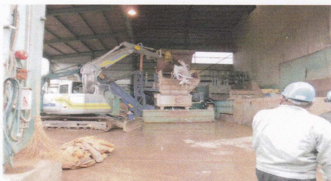
プラスチックサーマルリサイクル
