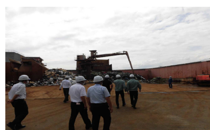
タワークレーン
